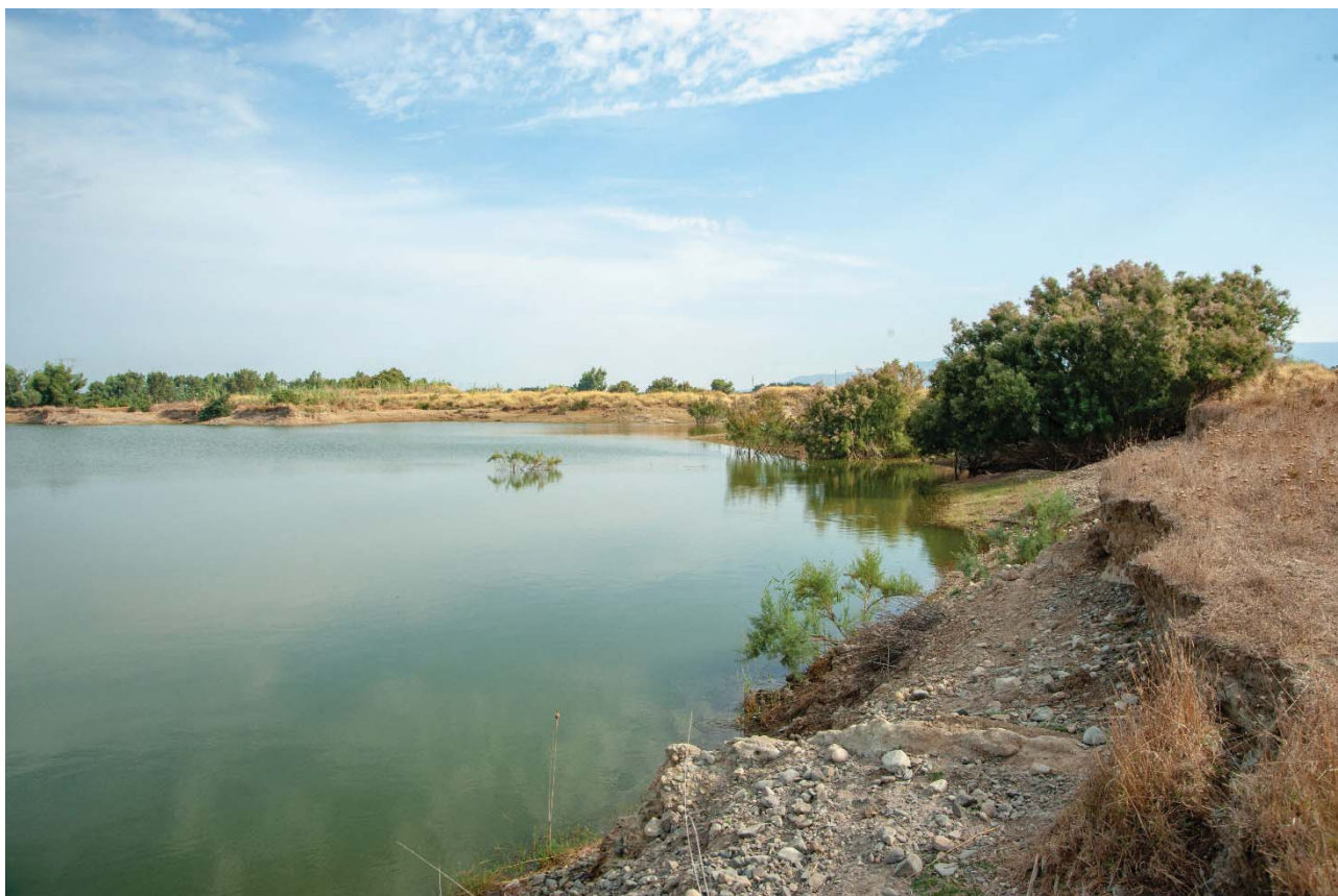
Figura 58 – tratti pericolanti in cui va attenuata la pendenza delle pareti (F017).
